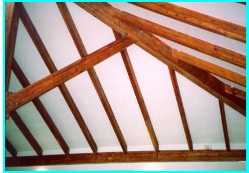
公衆浴場(温泉)の天井
