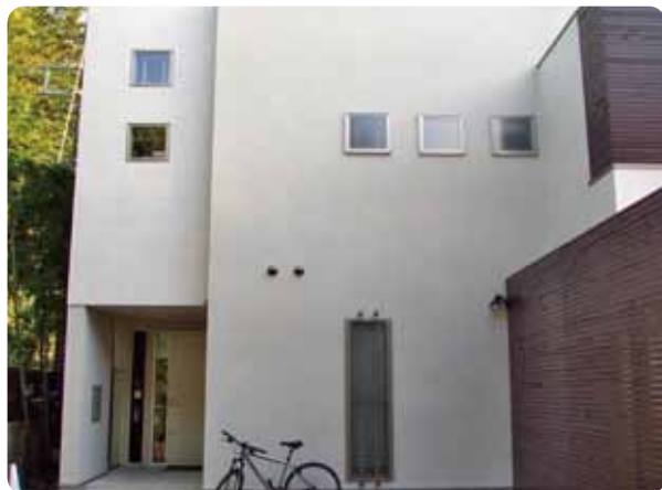
石灰系塗壁材の美観維持を目的としてのナノコートガードの塗布例。石灰系塗壁独特のあたたかみのある風合と色調を長期間に渡って保護します。
